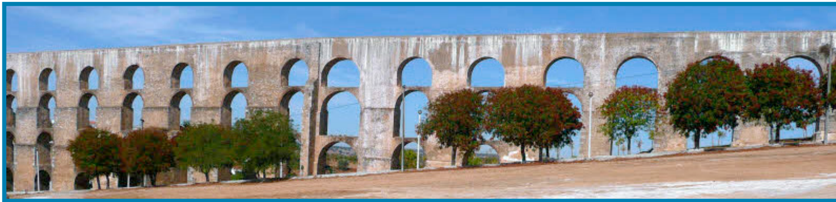
Imposant: Acht Kilometer lang und 30 Meter hoch ist das Aquädukt von Elvas, das den Besucher am Stadteingang empfängt.
